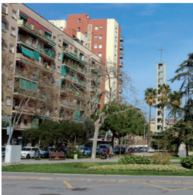
Vista actual de las Viviendas del Congreso del año 1952.
